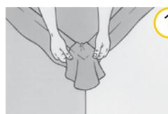
1 Rabattez la membrane à plat sur le bord de la toiture. Le pli peut éventuellement être colmaté à l'aide de la **COLLE EPDM**.
