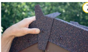
7 Colmatez l'extrémité du faîte en fixant la pièce de fermeture au-dessus des pièces de rive. Positionnez l'encoche en V au même niveau que le point le plus haut de la faîtière et fixez la pièce de fermeture. Repliez les parties verticales vers le toit.
