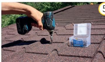
5 Vissez chaque panneau à l'aide du matériel de fixation prévu à cet effet. Utilisez 6 vis par panneau. Vissez toujours dans le creux de l'onde de la tuile, à 2 cm environ sous le rebord horizontal.
