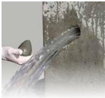
Produit d'étanchéité expansible, à durcissement rapide, pour colmater immédiatement les fuites dans le béton et la maçonnerie, même sous une pression extrêmement élevée. Colmatage efficace et permanent grâce à la dilatation expansive durant le séchage.
