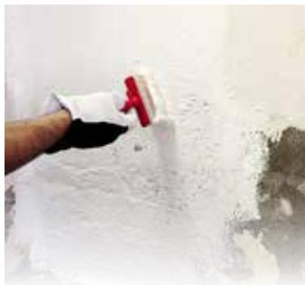
Revêtement bicomposant, résistant à l'usure et perméable à la vapeur d'eau, pour rendre étanches les murs et les sols partiellement ou complètement enterrés.
