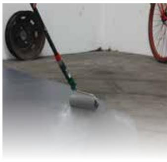
Revêtement de sol durable et hydrofuge, pour la protection des sols en béton contre les charges répétées dues, notamment, aux voitures. Prévient l'usure provoquée par les pneus chauds et protège le sol contre les taches, la graisse et le sel de déneigement. Grâce à sa composition spéciale, ce revêtement est hydrofuge et se nettoie aisément à l'aide de détergents ordinaires.
