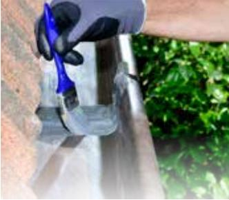
Répar' Gouttière est une pâte de réparation sans solvant, inodore et prête à l'emploi à base de polymères hybrides flexibles. La pâte répare les dégâts aux gouttières composées de tous les matériaux courants. Après durcissement, elle forme un revêtement imperméable, sans entretien, élastique et sans joint.
