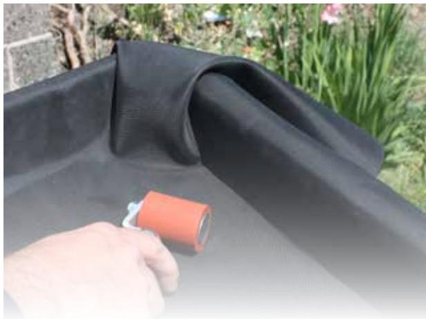
Le rouleau à compresser est le rouleau le plus couramment utilisé pour compresser uniformément les joints (soudures) et les membranes EPDM entre-elles, mais il est également largement utilisé pour compresser un ruban adhésif ou une bâche d'étang. Le rouleau est à double roulement, possède une poignée ergonomique et est donc confortable à utiliser pour rouler en douceur sur plusieurs mètres.
