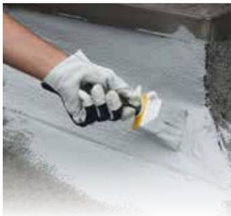
Couche de rénovation et/ou de réparation étanche, universelle et élastique. Convient pour presque tous les supports et peut être mise en œuvre par toutes les conditions météorologiques, même par temps de pluie.
