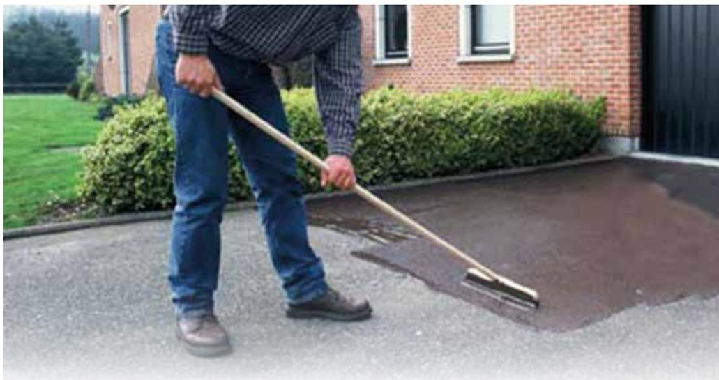
Émulsion de bitume universelle et souple, pour la rénovation extérieure des chemins, sentiers et allées asphaltés. Régénère le revêtement usagé en asphalté, comble les petits trous et fissures et prévient les dommages causés à l'asphalte par l'eau et le gel.
