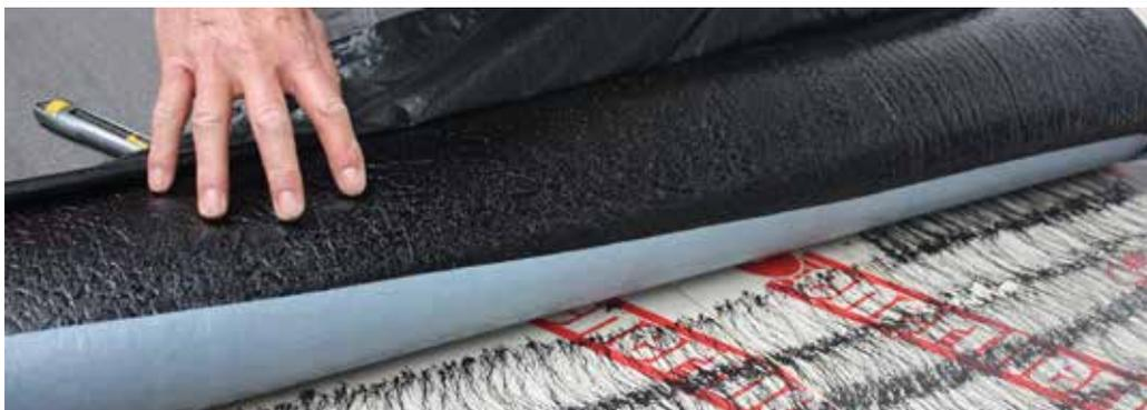
Le système autocollant est le moyen le plus sûr et le plus simple d'appliquer un revêtement de toiture en bitume. Les couches inférieure et supérieure sont munies d'un film amovible. Grâce à l'Activator, les conditions sont réunies pour une bonne adhérence du rouleau autocollant. Pour la couche supérieure, plusieurs couleurs de paillettes d'ardoises sont disponibles. Les paillettes claires sont réfléchissantes, pour rafraîchir la surface.
