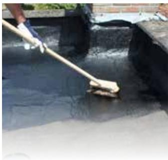
Vernis d'adhérence bitumeux à séchage rapide, afin de fixer les poussières résiduelles au support. Garantit une adhérence optimale du roofing neuf à poser ou des revêtements de rénovation.
