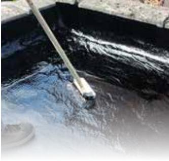
Revêtement de toiture étanche, renforcé par des microfibres, pour la réparation sans joints et la rénovation de toitures et gouttières anciennes et abîmées.
