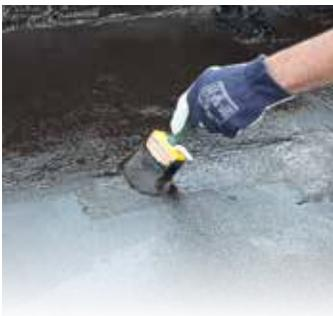
Un revêtement d'entretien renforcé à l'aide de fibres, pour la réparation, la protection et l'étanchéité des toits bitumeux plats et légèrement inclinés ainsi que des gouttières. Après séchage, forme une couche bien adhérente et légèrement élastique qui colmate tous les pores et toutes les fissures.
