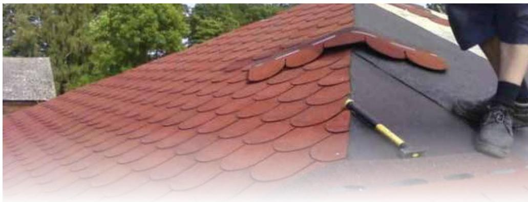
Bardeaux munis d'une armature en voile de verre imputrescible, pour l'étanchéité esthétique des toits inclinés. Compte tenu de son faible poids par m<sup>2</sup>, par rapport à d'autres matériaux d'étanchéité de toiture, une charpente plus légère et moins coûteuse peut être utilisée.
