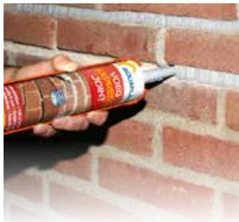
Joint-Express d'Aquaplan est un mortier de jointoiment qui permet de réparer aisément les joints de maçonnerie et les fissures dans le béton. Joint-Express s'applique très facilement, à l'aide d'un pistolet à mastic. Ce mortier de réparation des joints possède une bonne adhérence sur la plupart des matériaux de construction et résiste déjà à la pluie quelques heures après son application. Joint-Express est ponçable et recouvrable.
