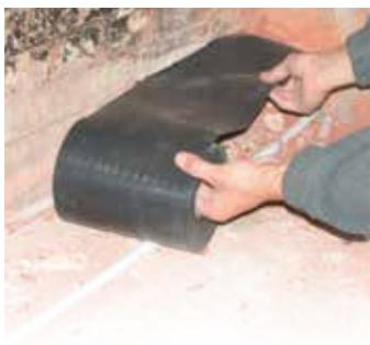
Membrane d'étanchéité synthétique, imputrescible et indéchirable, contre l'humidité ascensionnelle dans les murs intérieurs et extérieurs. Munie d'un profilé gaufré afin de permettre une meilleure adhérence du mortier et d'éviter que la membrane ne glisse.
