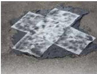
Bande de renforcement en polyester pour la réparation des toitures.
