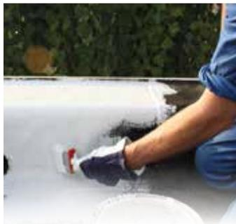
Peinture acrylique blanche prête à l'emploi, utilisée afin de rendre réfléchissantes les toitures plates et en pente, mais aussi de les rénover. Ce revêtement de rénovation permet également de rafraîchir les revêtements de toiture en bitume usés par les intempéries.
