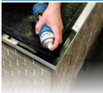
Primaire bitumeux à séchage rapide, pour l'activation et la préparation des supports sur lesquels des produits de toiture sont posés. L'adhérence est ainsi améliorée lors de l'utilisation de roofing, de produits d'entretien et de réparation liquides.
