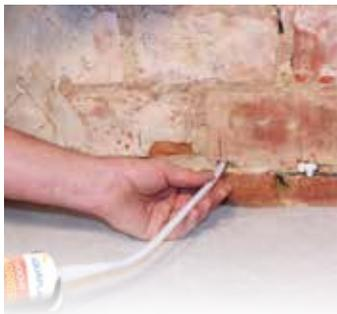
Un gel d'injection sans solvants et prêt à l'emploi, afin de lutter contre l'humidité ascensionnelle dans les murs. A l'aide d'un pistolet à cartouche, s'injecte facilement et rapidement dans des trous percés dans un joint horizontal du mur.
