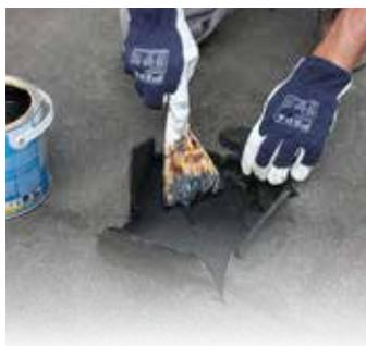
Pâte de réparation étanche et souple, afin de réparer les fissures, les crevasses et les boursoufflures sur les toitures et les gouttières. Finition résistante aux intempéries de tous les détails de la toiture tels que les rives, les évacuations d'eau, etc.
