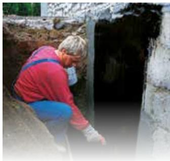
Émulsion de bitume universelle et souple, sans solvants, pour rendre étanches tous les matériaux en contact avec l'humidité souterraine. S'utilise sur la face extérieure et peut être appliqué sur un support légèrement humide.
