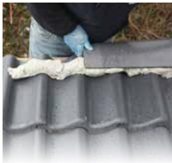
Mortier de réparation de toiture prêt à l'emploi afin de fixer et de réparer les tuiles, les faîtières et les raccords en plomb de manière à ce qu'ils résistent à la tempête.
