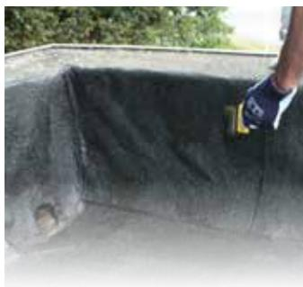
Un vernis d'adhérence incolore et prêt à l'emploi qui sèche rapidement, pour la préparation de divers types de supports avant l'application d'un revêtement de toiture non bitumeux.
