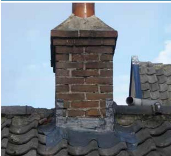
Véritable plomb muni d'une couche de butyle autocollante, facile à mettre en œuvre sur les toits et les façades. Résiste très bien à la corrosion atmosphérique, possède une longue durée de vie et est résistant aux UV.
