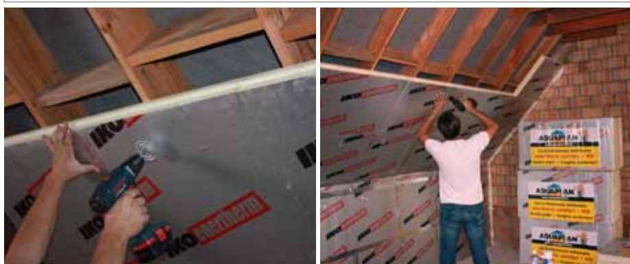
Hellend dak (zolder)
