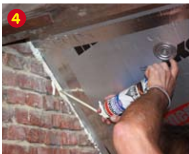
4 Smit de naden tussen het hout/ stenen en de enertherm Comfort Alu TG platen af met PU-schuim.
