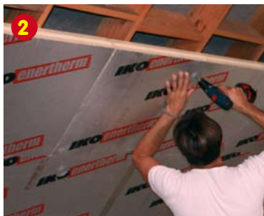
2 Schroef de enertherm Comfort Alu TG plaats vast met minstens 2 schroeven met rondel.
