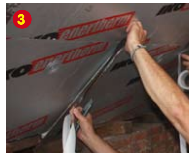
3 Kleef nu alle naden tussen de enertherm Comfort Alu TG platen af met Alu-Tape.
