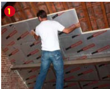
1 Plaats de eerste rij enertherm Comfort Alu TG horizontaal zodat de tand- en groefverbinding goed sluit.
