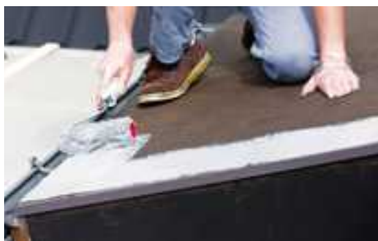
Een aluminiumkleurige dakvernieuwer of coating beschermt beter tegen uv-stralen.
