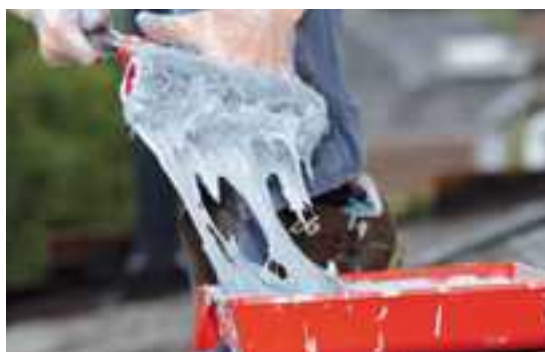
Dakvernieuwers zijn vaak dikvloeibaar, waardoor ze zich niet altijd even vlot laten uitsmeren.
