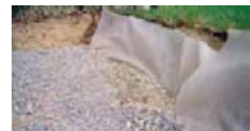
Photo 4 Chantier en cours de réalisation
